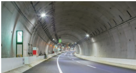
横浜環状北西線シールドトンネル (神奈川県)
