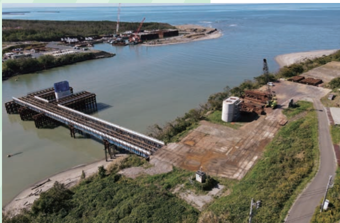
新野積橋橋脚
