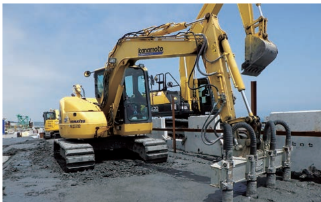
アッシュクリートの施工状況
