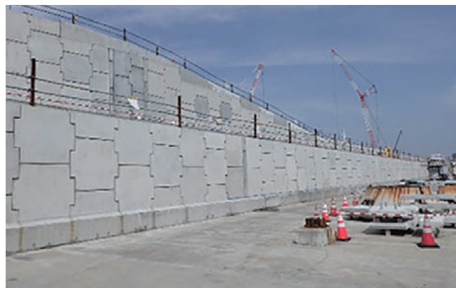
完成した防潮堤の一部
