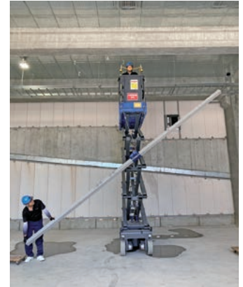
角パイプの建て起こし状況
