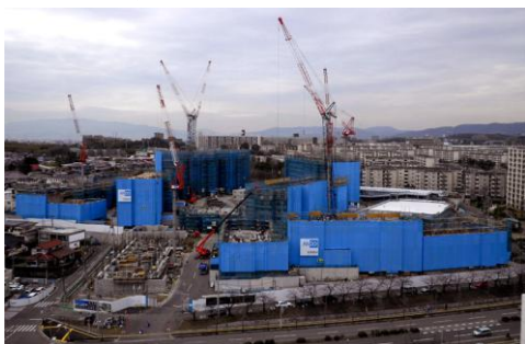
千里桃山台第2団地住宅建替事業 (2012年4月完成、西日本最大)
