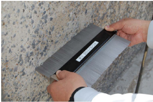
写真-1 打継目の凹凸深さの測定
