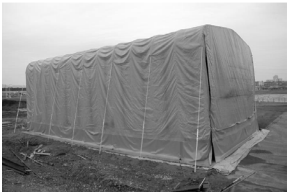
写真-5 仮設テント
