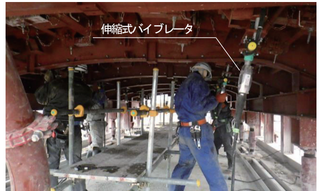
写真-14 伸縮式バイブレータ使用状況
