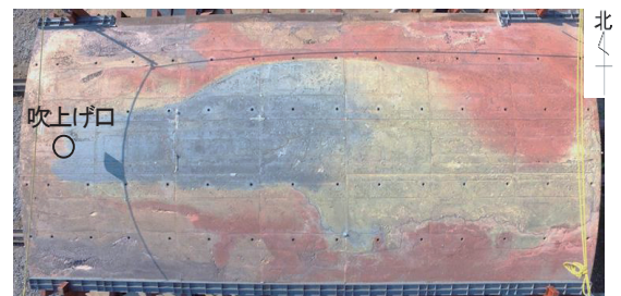
写真-8 硬化後充填状況 (改善実験1: 上面)
