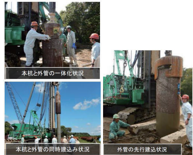
図-3 施工性確認試験での施工状況
