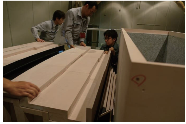
④ 天井材の設置
