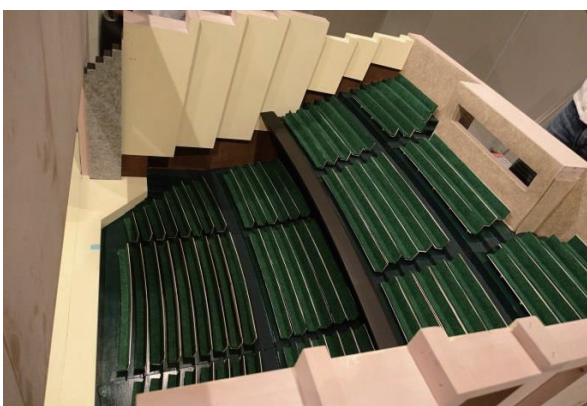
③ ステージ廻りおよび側壁の組立
