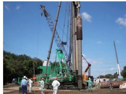
図-2 二重管杭の建て込み状況
