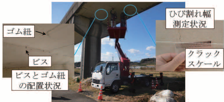
(c) 高所作業車を用いた計測
