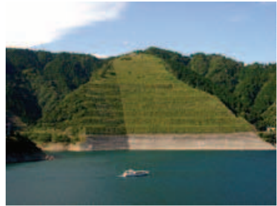
写真-2 宮ヶ瀬ダム原石山法面
