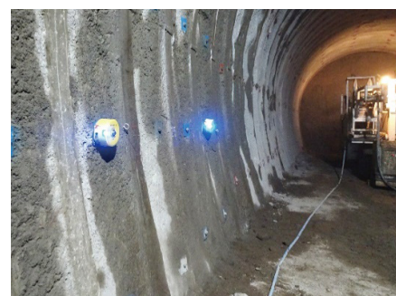
写真-3 受振ユニットの設置状況
