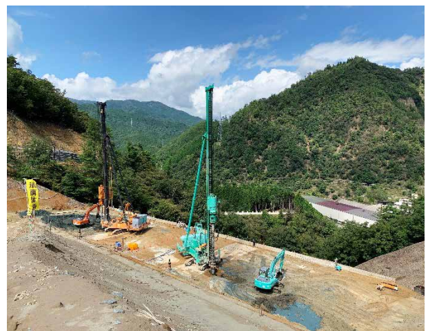
写真-1 下層部地盤改良状況
