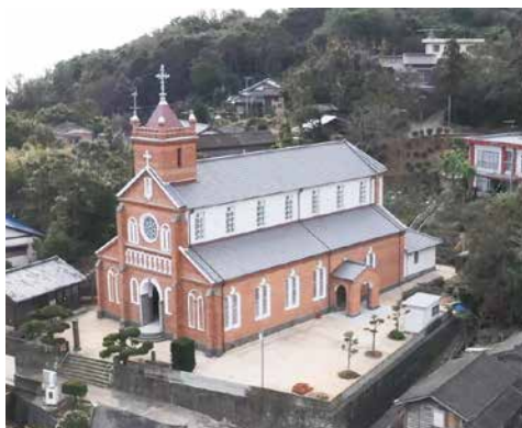
写真-1 黒島天主堂外観 佐世保市教育委員会提供(工事期間中に撮影)
