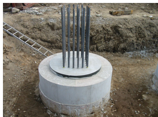
写真 1 試験体出来型(施工実験)
