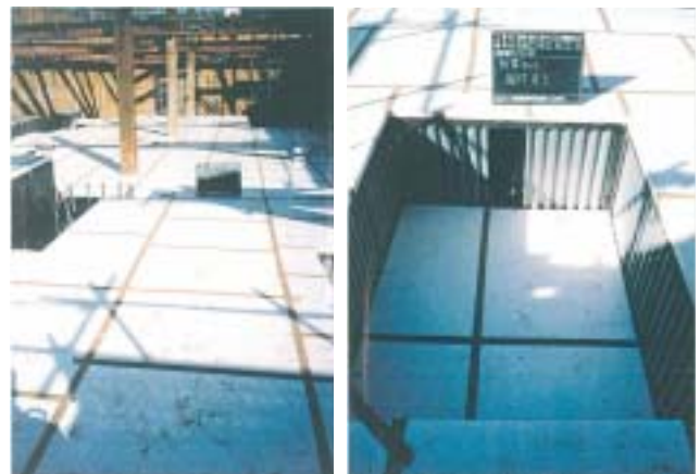
図9 敷設施工中の防振マット
