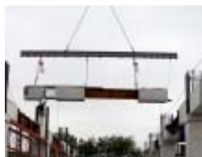
写真4 梁建て方状況
