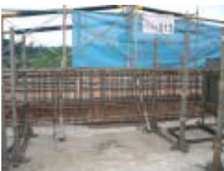
写真1 柱筋水平組み
