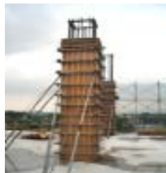
写真2 柱型枠状況
