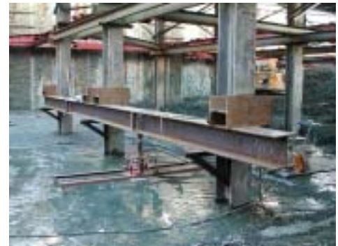
写真 2 静的平板載荷試験（北側）
