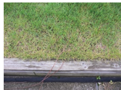
写真1 芝施工土内部温度計測状況
