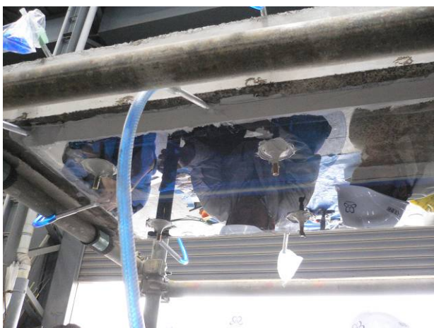
写真9 試験体 C3(注入中)
