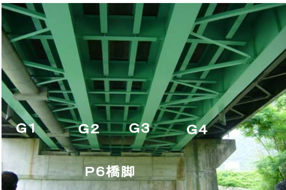
写真-3 橋梁下面の状況
