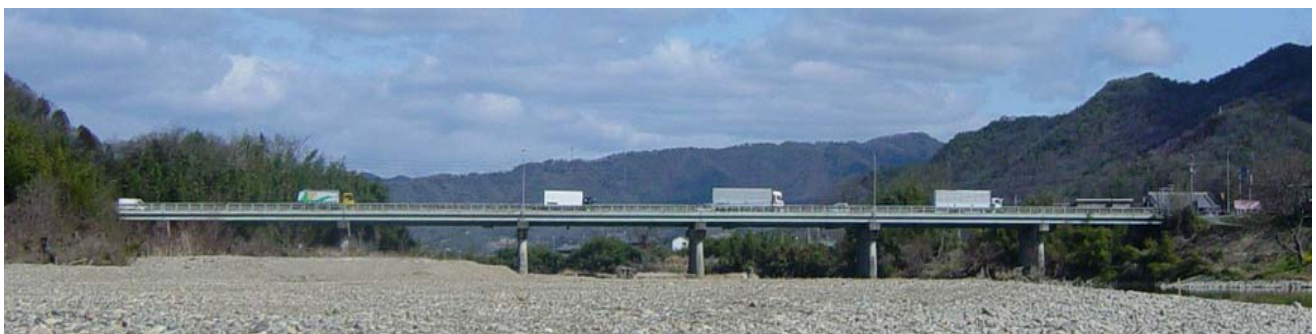
写真-1 対象橋梁の全景
