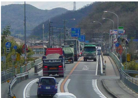
写真-2 道路面の状況
