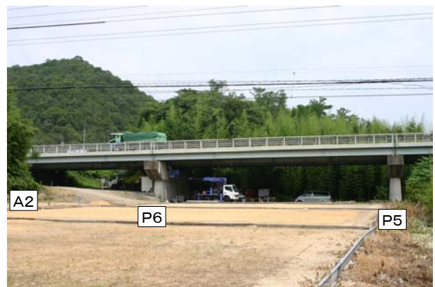
写真-4 計測区間
