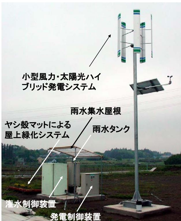
写真-2 屋上緑化灌水システムの概観
