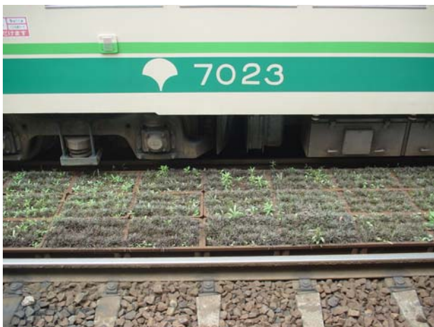
写真-8 東京都交通局の軌道緑化(町屋駅前)
