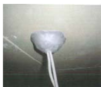
図-21 電気配線貫通部施工状況
