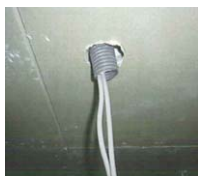
図-21 電気配線貫通部施工状況
