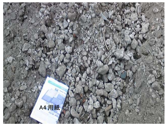
写真-6 55mmふるい下のコンクリートがら破碎物
