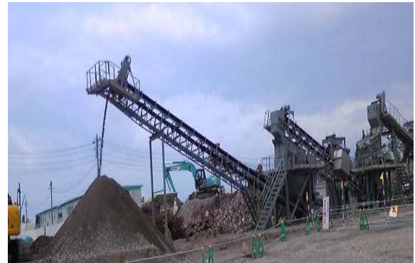
写真-5 コンクリートがらの破碎分別状況
