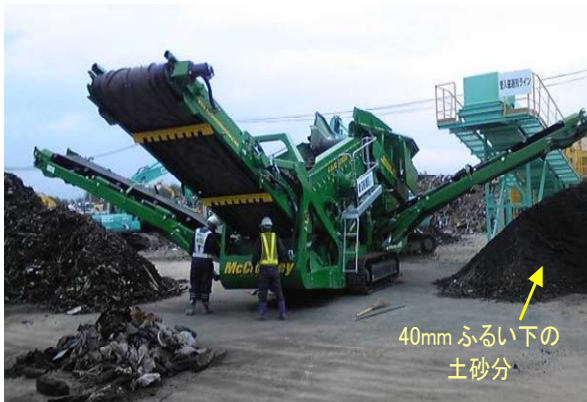
写真-1 廃棄物混じり土砂の処理状況
