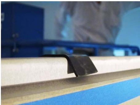
写真-5 押出成型セメント板のスペーサー
