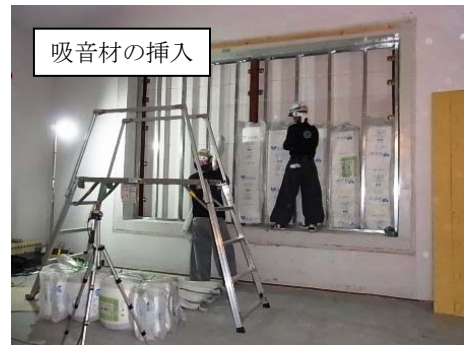
石膏ボードの施工
