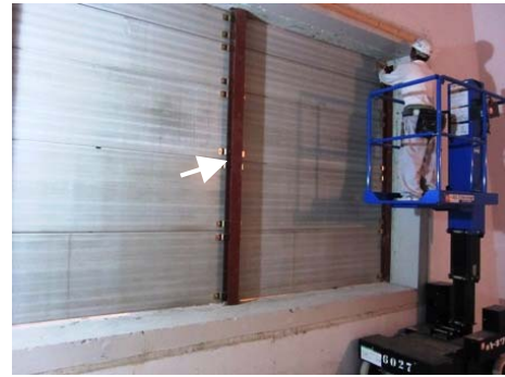
写真-7 セメント板施工状況
