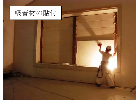
吸音材の挿入
