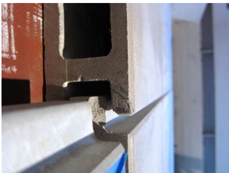
写真-6 セメント板施工状況
