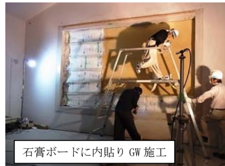
写真-4 試験体施工風景
