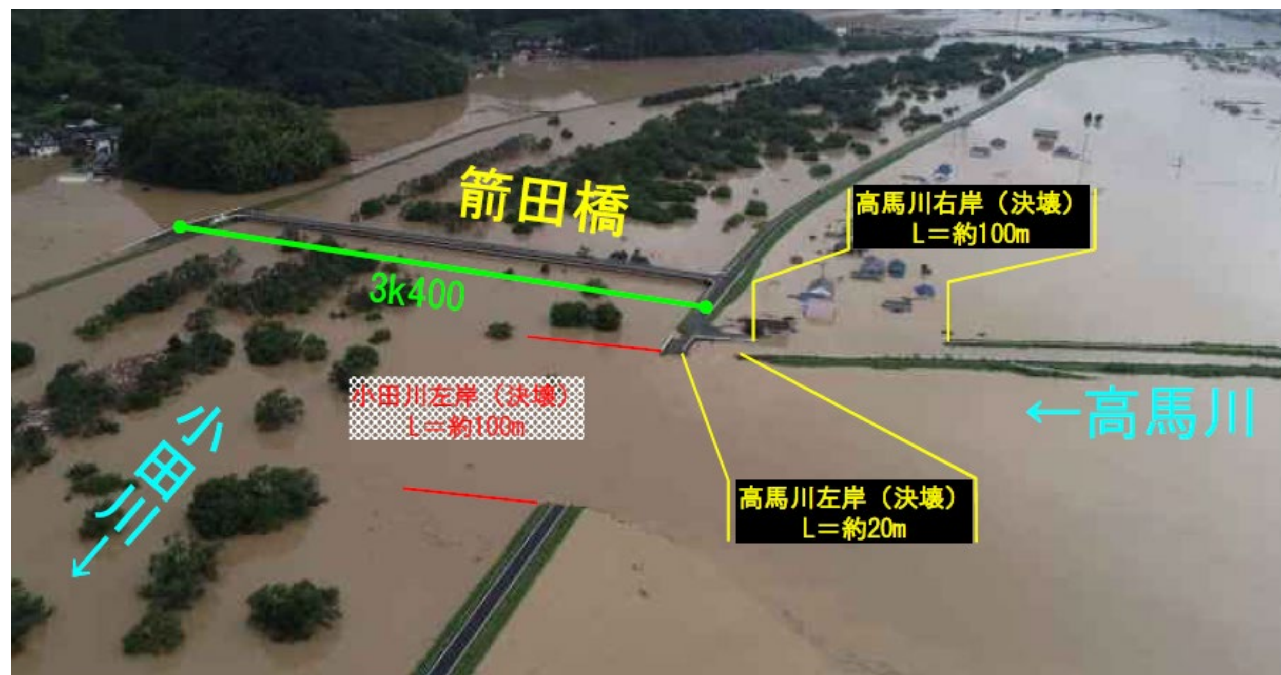
堤防破堤 (中国地方整備局)
