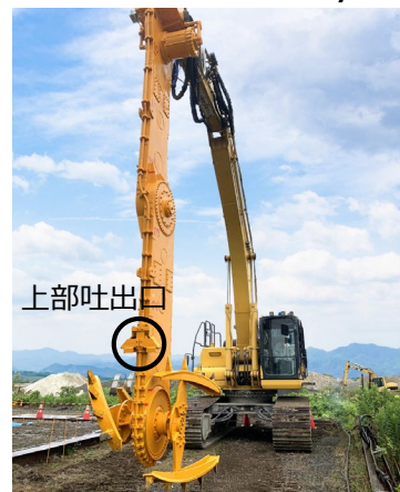
WILL-m工法 施工機械
