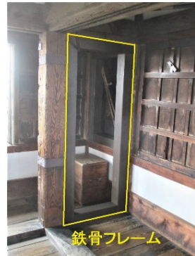
五階鉄骨フレーム (木製カバーで化粧)
