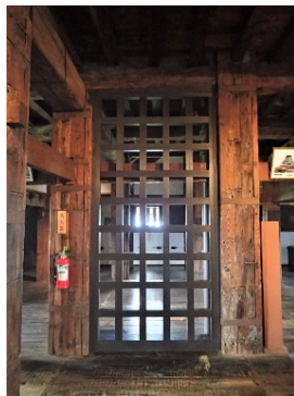
三階木格子設置状況 ※天守のオリジナル材(松)と識別できるように松材を使用
