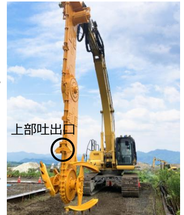
WILL-m工法 施工機械
