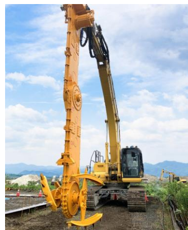
WILL工法 施工機械
