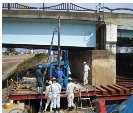
施工例②：昭栄大橋左岸橋脚補強工事 (新潟県三条市)
