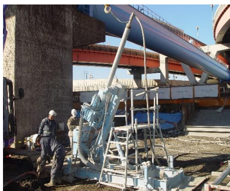
施工例①：綾瀬川水管橋耐震補強工事 (東京都足立区)
