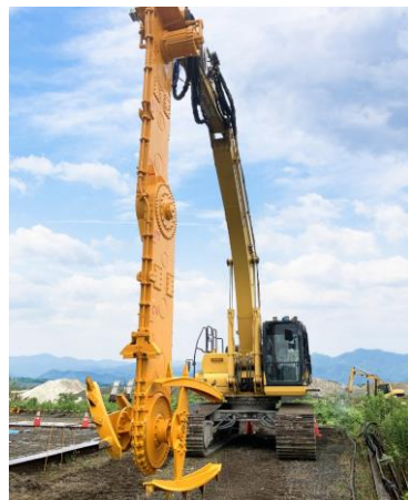
WILL工法 施工機械
