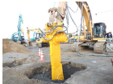
透水性改良体造成状況
