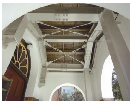
側玄関鉄骨フレーム
