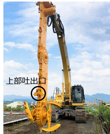
WILL-m工法 施工機械
