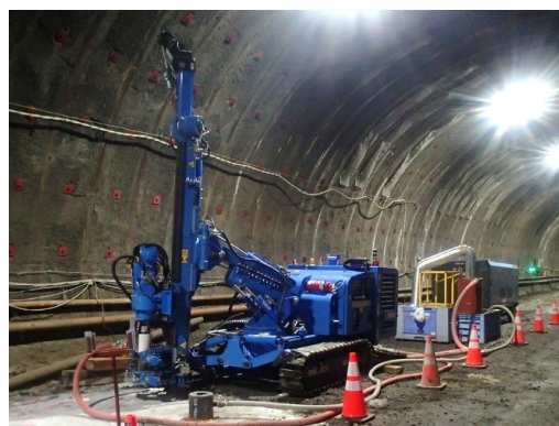
実トンネル内での試験施工状況
