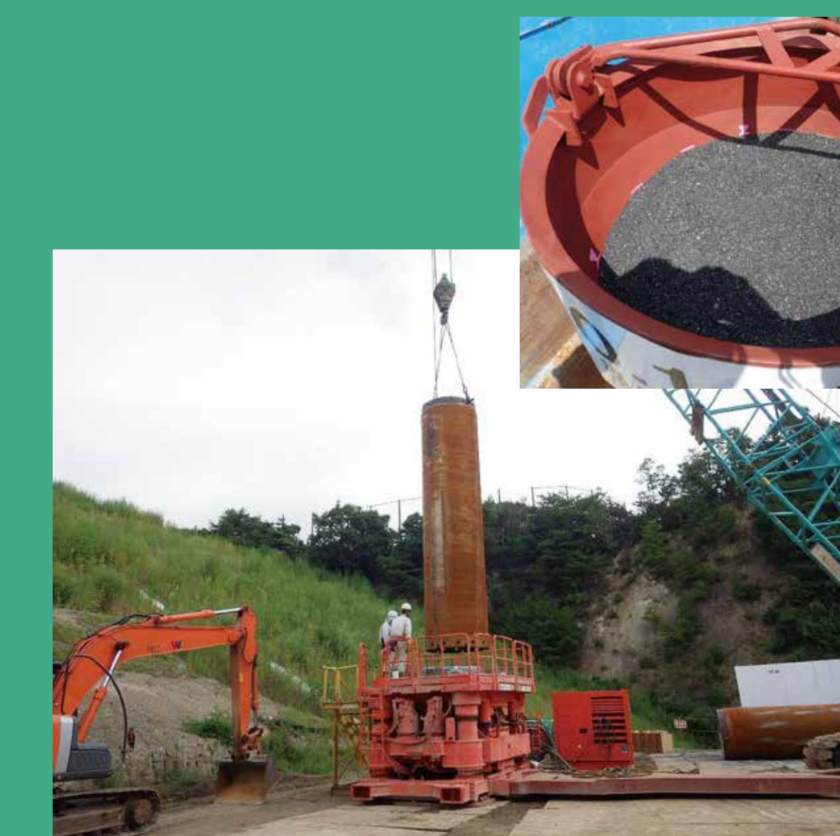
透過壁（ケーシング）設置状況
