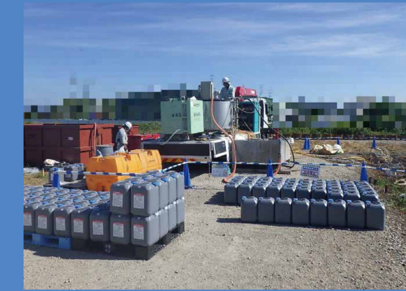
薬剤注入状況
