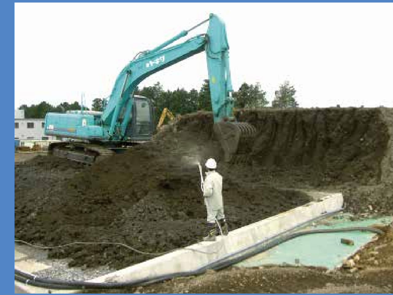
栄養剤散布状況
