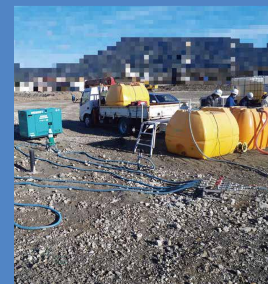
薬剤注入状況
