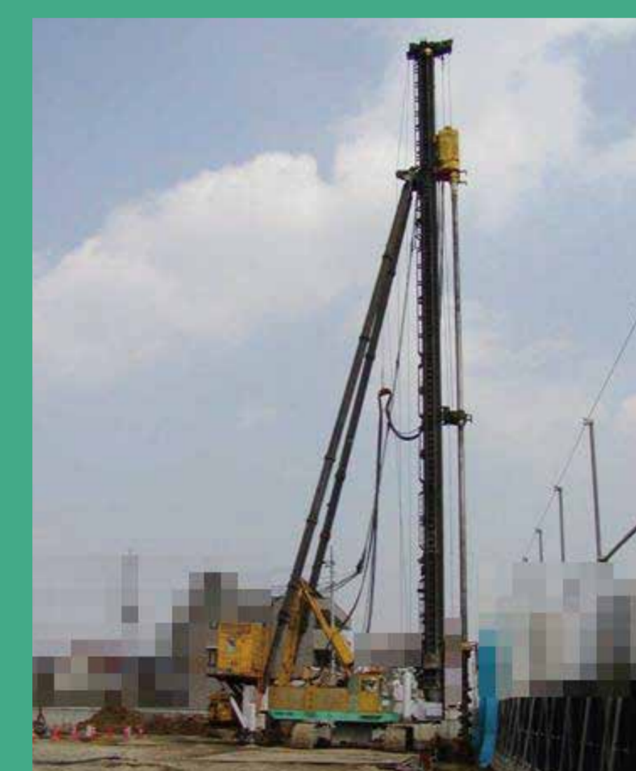
遮水壁設置状況
