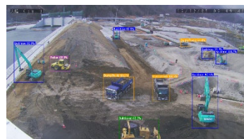
建機検出AIによる識別結果
