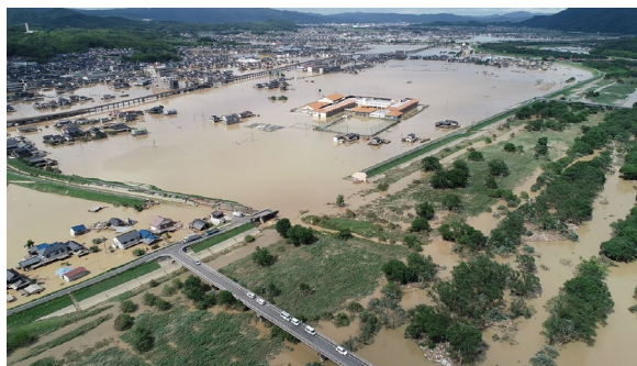
平成30年7月豪雨堤防被害 (小田川、岡山県) 出典：国土交通省中国地整HP
