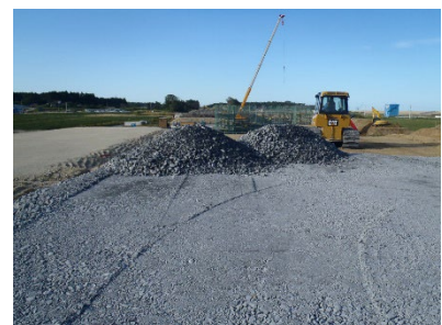
路盤材 (破碎材)
