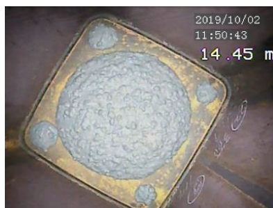
CFT柱の充填コンクリート 高強度・高流動な低炭素コンクリート
