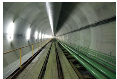
北浜逢阪貯留管築造工事(合流式下水道) 外径φ6,600mm×厚さ300mm×幅1,500mm 大阪府
