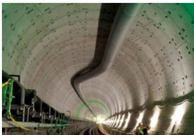
中央環状品川線大橋連絡路工事(道路) 外径φ9,500mm×厚さ350mm×幅1,500mm 東京都
