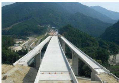
古川高架橋(壁高欄) 三重県
