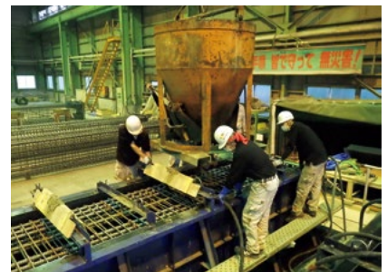
3 コンクリート打設
