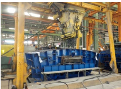
3 コンクリート打設
