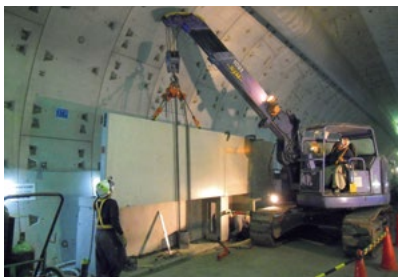
中央環状品川線大橋連絡路工事(避難通路) 東京都
