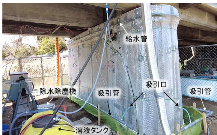
供用中の市道橋脚への適用状況（再アルカリ化）
