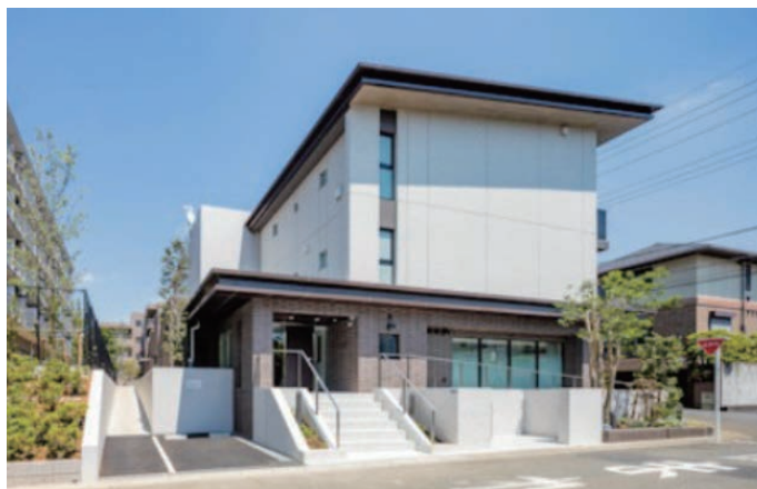
図 共同住宅(寮)完成写真
