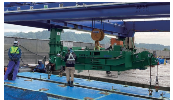
当装置を用いた施工状況
