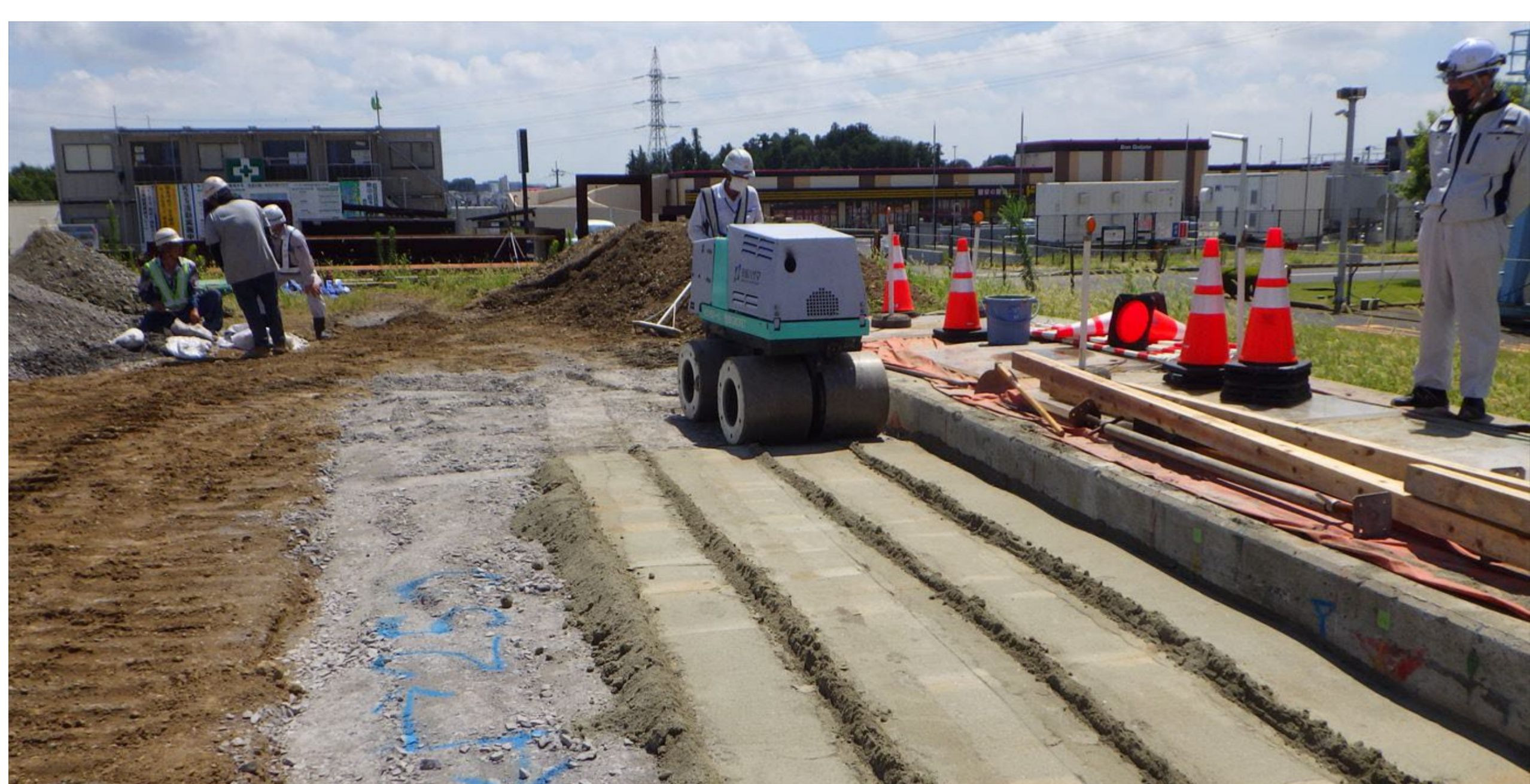
図3 転圧状況の例
