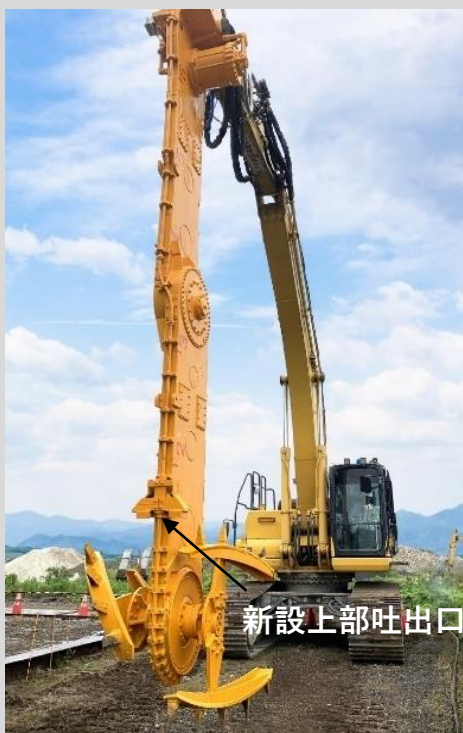
施工機械全景
