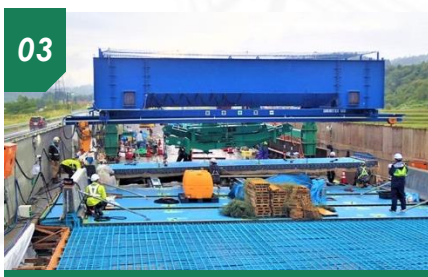
03 現場のクレーンで約12トンの床版を吊上げ・組立
